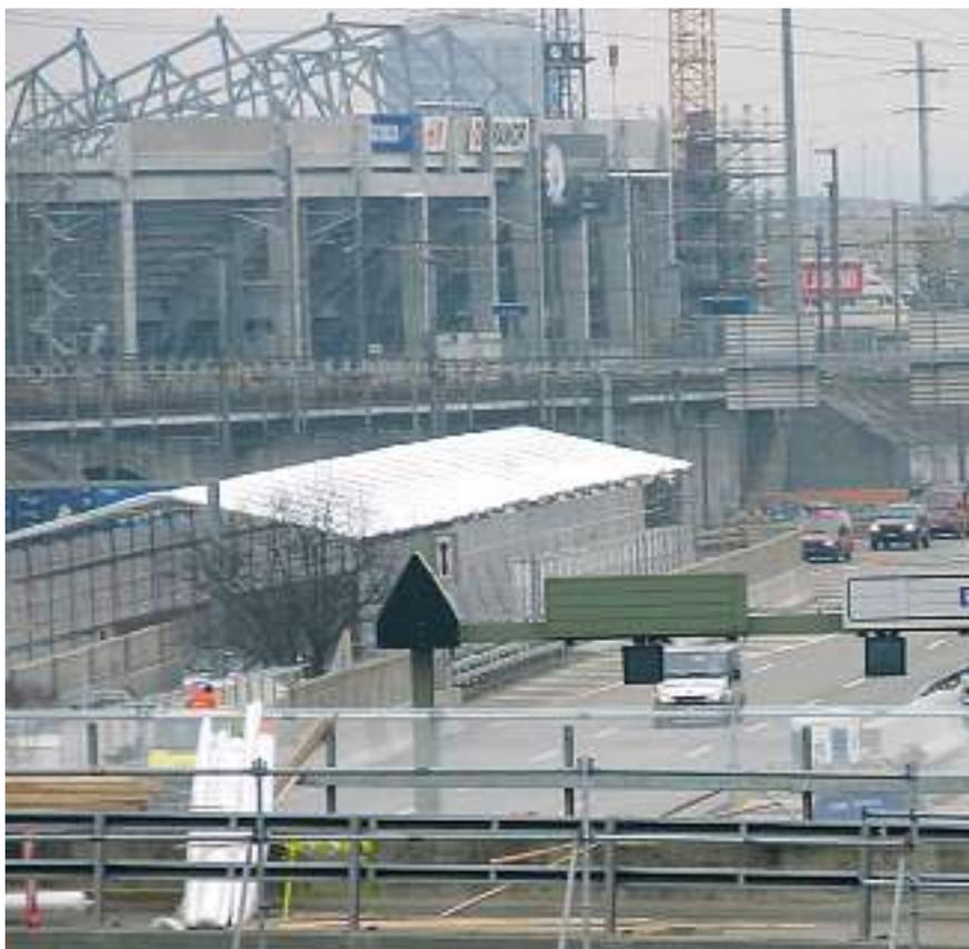
Einbau eines Verkehrsleitsystems, Anpassung der Galerie Schweizerhalle an die neuesten Richtlinien betreffend Tunnelsicherheit (insbesondere Lüftungsanlage).
