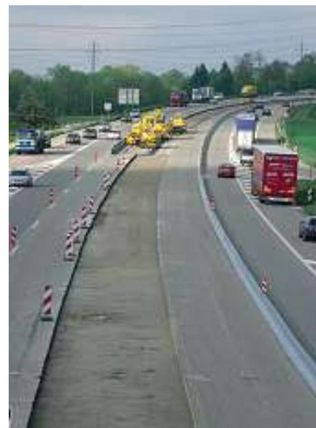
Lehnenviadukt bei Würenlos: Ausbau der alten 35t schweren Brückenelemente
